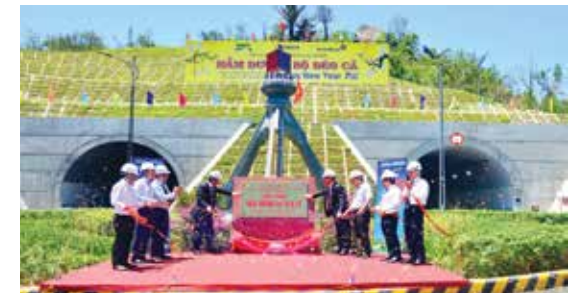
Gắn biển công trình tiêu biểu Hầm đường bộ Đèo Cả Kỷ niệm 60 năm truyền thống ngành Xây dựng Việt Nam
