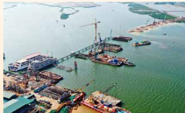
↳ Công trường thi công Cầu Cửa Lục
